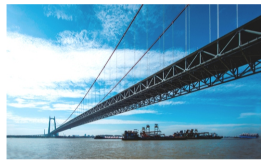
湖南省临湘至岳阳高速公路洞庭湖大桥
