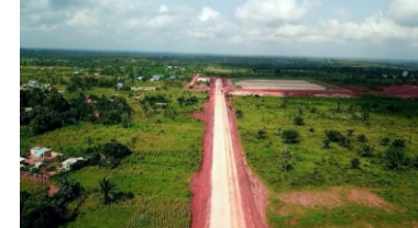
掩埋场进出场道路
