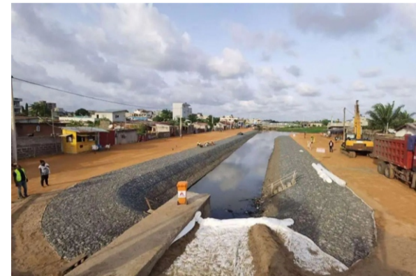
河道宾格网护坡施工
